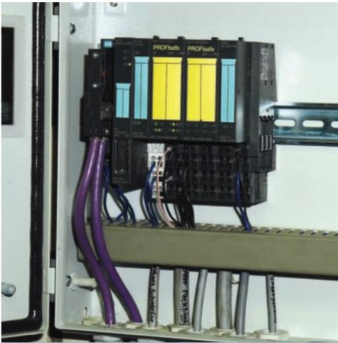
Für die Signalbündelung der dezentralen Sicherheits-schaltgeräte sind fehlersichere Module gut geeignet.
