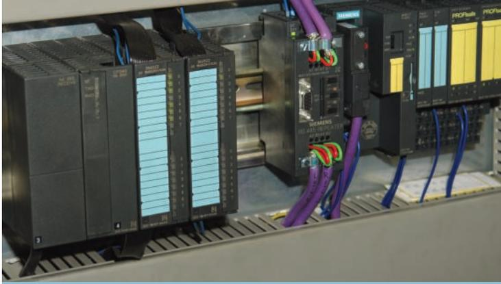
Um unterschiedliche Sicherheitskonzepte umzusetzen wird eine ET200S High Feature mit fehlersicheren Modulen über Profisafe an die Steuerung des Subsystems angehängt.
